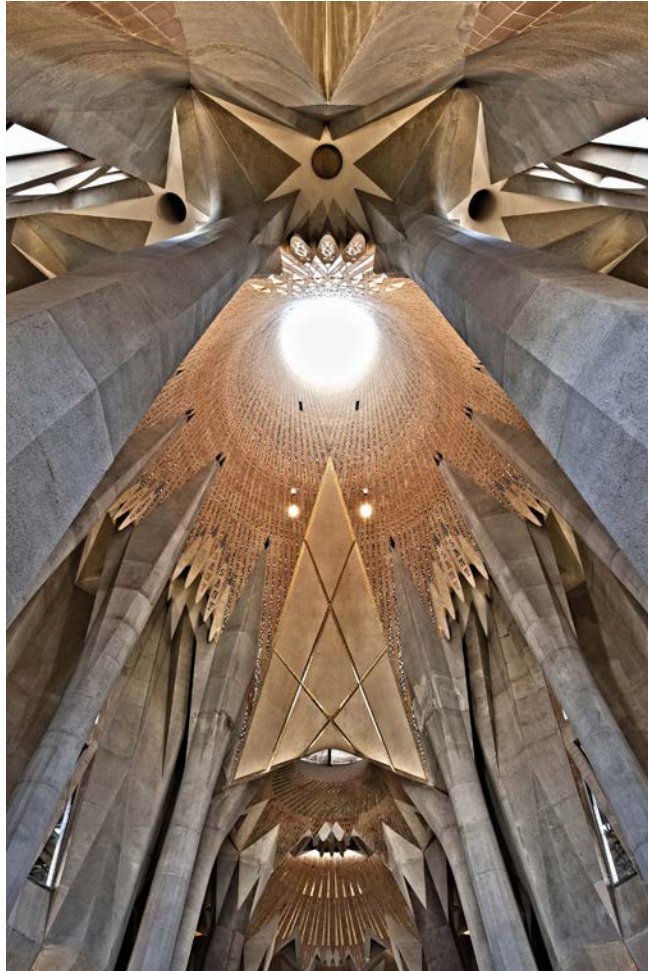
La lluminosa volta hiperbòlica de l'absis.
